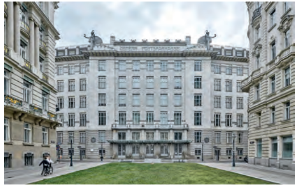
108. Wien I, Postsparkasse, Aufnahme 2020
